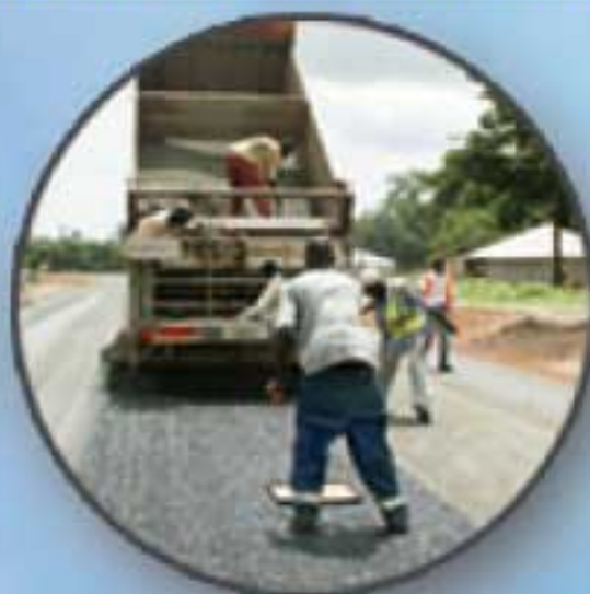
Aménagement de chaussées
